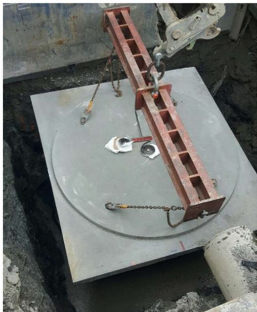
FIGURE 2: PRÉPARATION DE L'ASSISE
