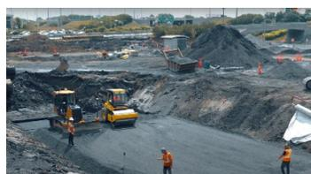
Si spécifié aux plans, installer un drain pour l'assèchement de l'assise, puis niveler l'assise (pierre MG-20 ou sable MG-112) et compacter à au moins 90% du Proctor modifié (P.M.). Il est essentiel de déposer le système sur une surface plate, solide, horizontale et stable, surtout pour des systèmes étagés ou des systèmes supportant des charges de circulation. Une épaisseur d'assise minimale de 150 mm est requise.
